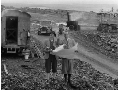
Bau der Hunsrückhöhenstraße 1938. Die Ingenieure Piritz (Johannes Metzendorf) und Otto Wohlleben (Jörg Hube). ( Kapitel 3 )
